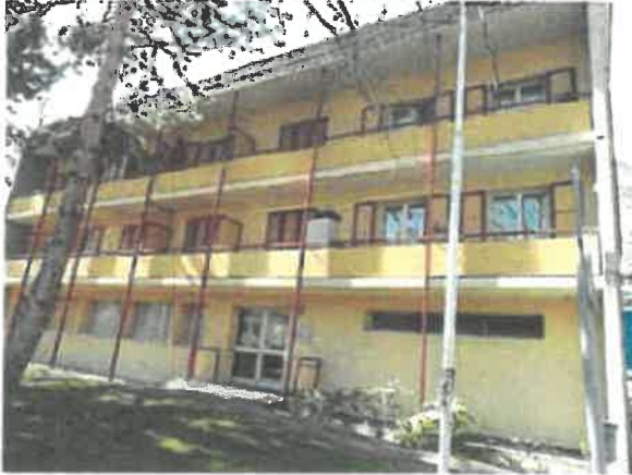
Vue façade Sud-Est
